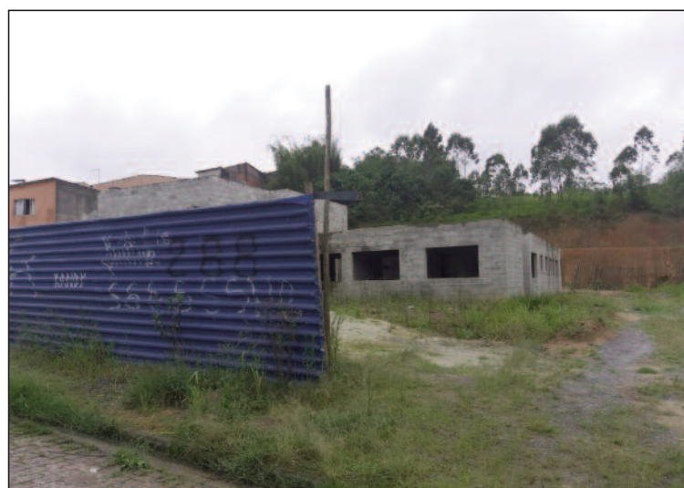
Obra fica aberta, sem qualquer restrição de entrada para a população
