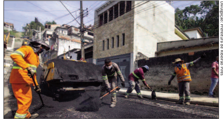
Ação de recapeamento asfáltico no Jardim Caçula
