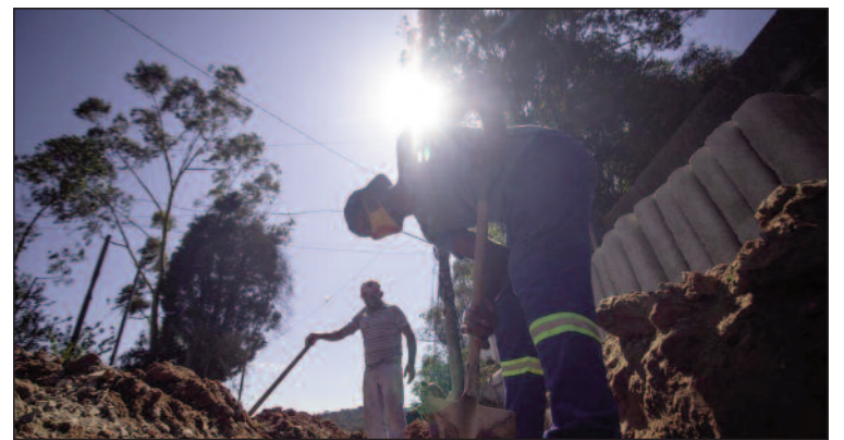
Instalação de guias e sarjetas estão em finalização, na rua Passo Fundo
